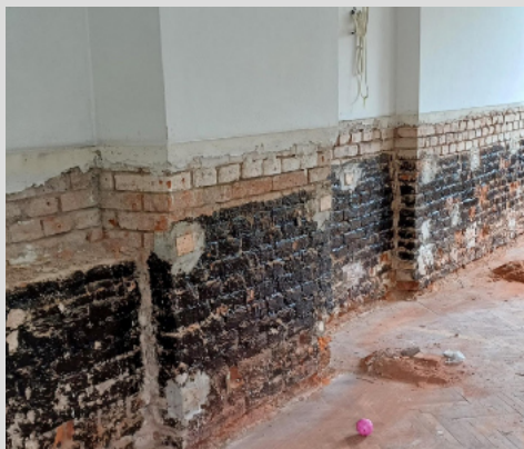
Stav tělocvičny před rekonstrukcí
